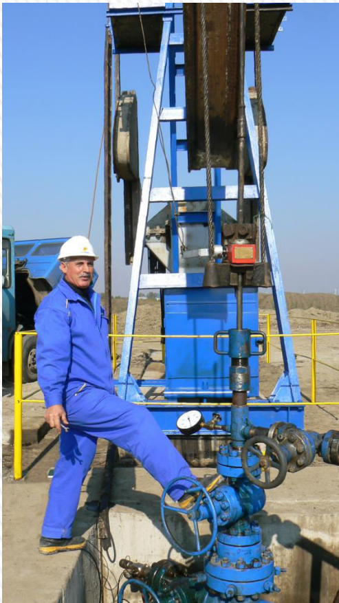
Fig. 1 Unitate de pompare de 15 t echipata cu rotator de prajini
